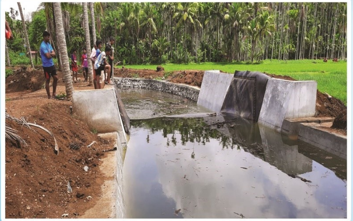
അലന്തട്ട നപ്പച്ചാൽ തോടിലെ റബ്ബർ ചെക്ക് ഡാം
